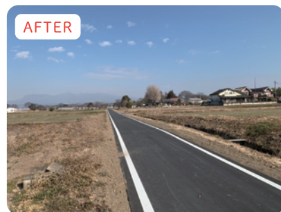
西大室町農道改修後
