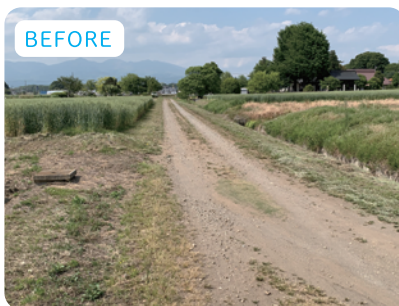
西大室町農道改修前
